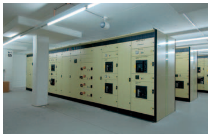
Bild 1 Briefzentrum Zürich-Mülligen Bild 2 Sortieranlagen Bild 3 Niederspannungs-Hauptverteilung
