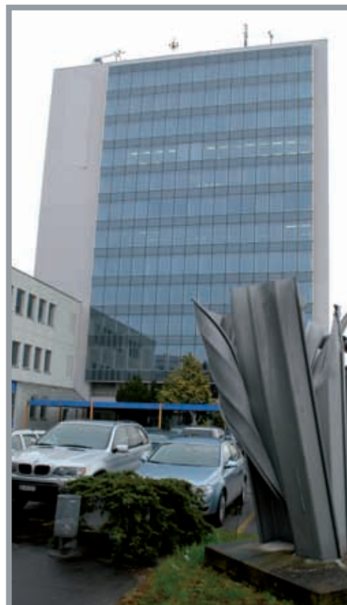
Das Hochhaus der Schlatter AG, seit 1964 der markante Bau im Industriequartier Schlieren.
