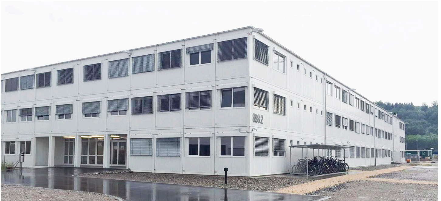
Der Modulbau von Roche in Kaiseraugst bietet Platz für rund 250 Mitarbeitende
