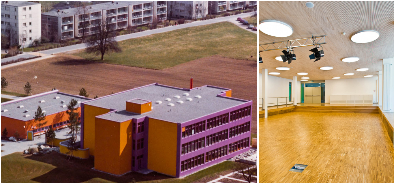
Das neue Schulhaus Hasel und die frisch sanierte und vergrösserte Turnhalle (Foto: Jiri Vurma)
